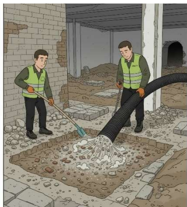
Scavo di cantine e locali interrati in edifici esistenti
