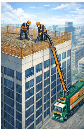
Aspirazione di ghiaia e materiali in copertura
